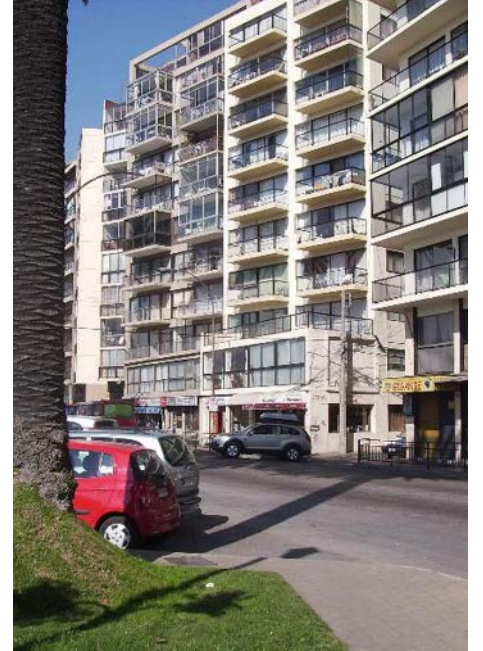
Av. La Marina (entre Von Schroeders y Ecuador)
