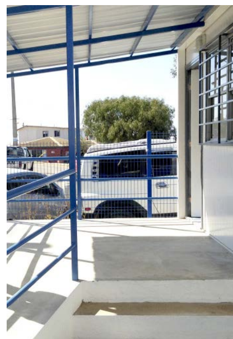
Modificación acceso Laboratorio Comunal y habilitación del PNAC en CECOSF Las Palmas $17.000.000 total
