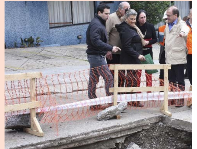
Reposición del colector de aguas lluvias Barros Arana, en Reñaca
