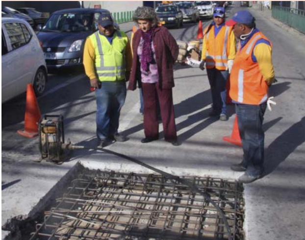
Obras de emergencia en el colector de aguas lluvias en Traslaviña, entre calles Viana y Arlegui
