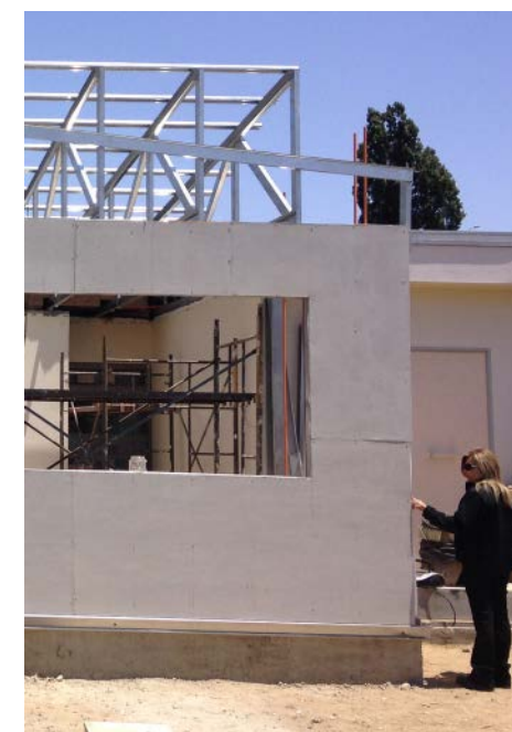
Construcción de una Sala de Educación en CECOSF Villa Hermosa $21.000.000
