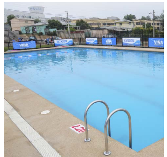
Construcción Piscina Municipal Miraflores
