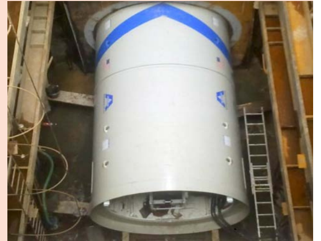
Obras de conservación en el colector de aguas lluvias de calle Von Schroeders
