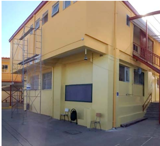
Reconstrucción Escuela Ministro Zenteno, afectada por un incendio $247.000.000
