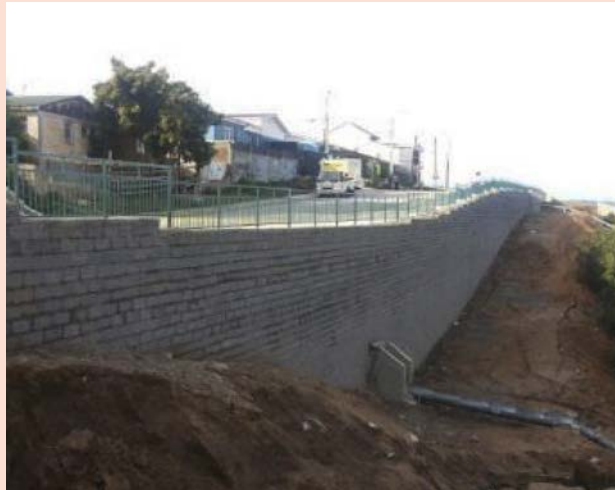
Mantención sistemas de evacuación de aguas lluvia
