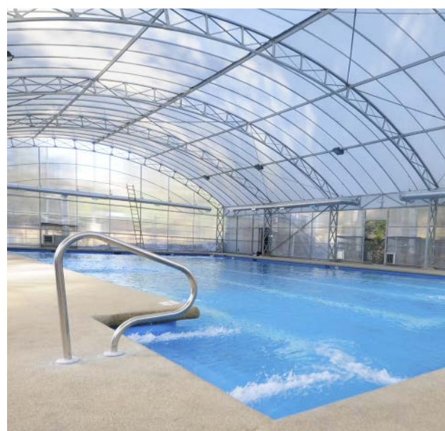
Construcción cubierta piscina Parque Urbano Forestal
