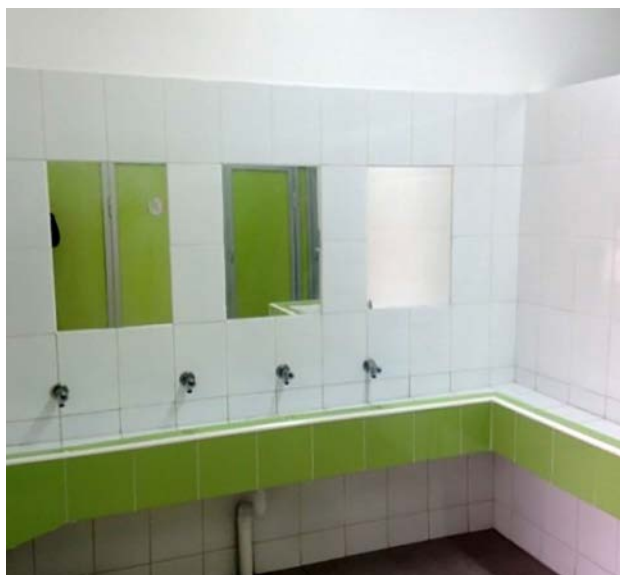
Reposición baños y cambio de cubierta Escuela Almirante Gómez Carreño $54.000.000
