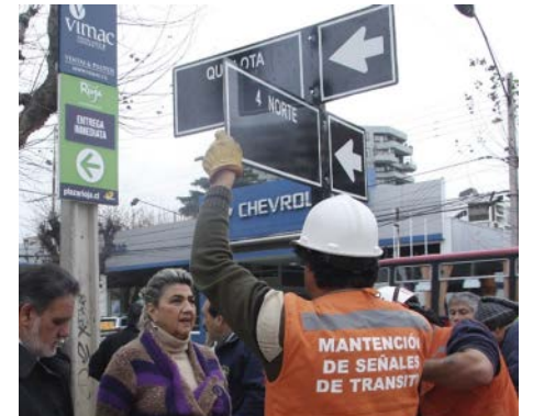
Reparación señaléticas de tránsito
