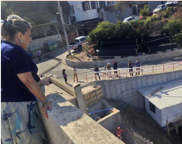
Obras en el colector Las Golondrinas en Reñaca
