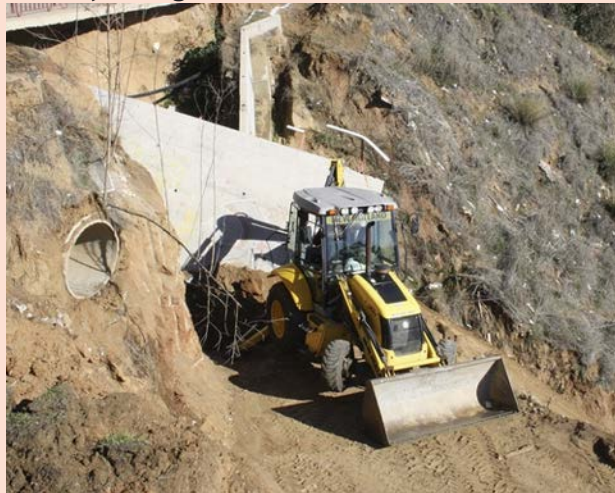
Obras de conservación en la red primaria y drenaje de aguas lluvias en la comuna
