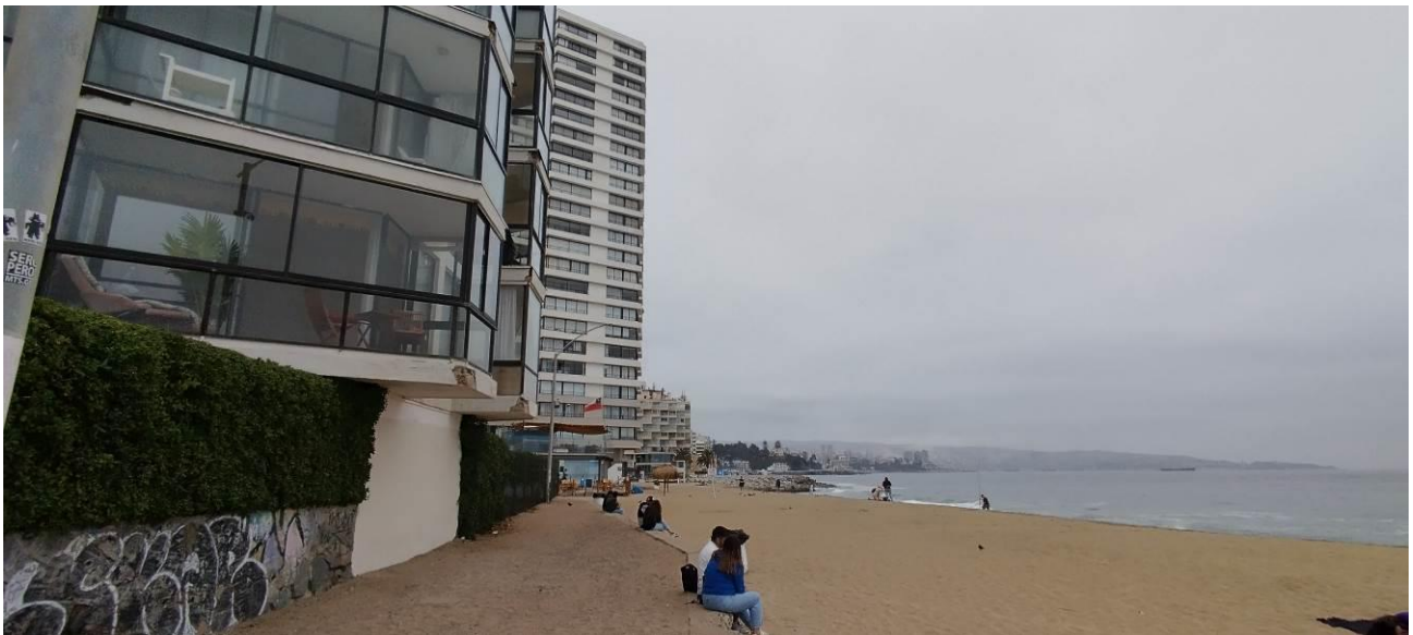
Fotografía 2: Situación actual de la playa Acapulco sin pasarelas.
