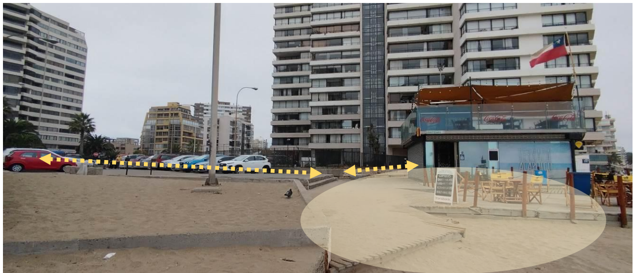
Fotografía 3 superior izq: Acceso desde sur sector av. Perú bajo edificio Acapulco – Fotografía 4 superior der: Acceso desde San Martín por calle 9 norte – Fotografía 5 inferior: Sector de confluencia de ambos accesos en el entorno del café Terraza Acapulco.
