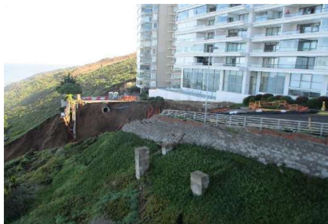
Trabajos reposición colector e infraestructura Contratista MOP
